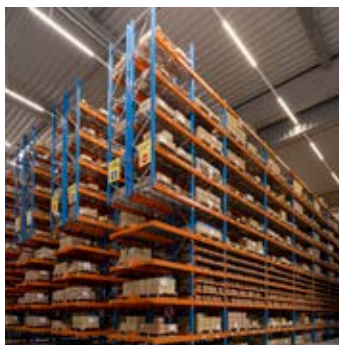
LOGISTIQUE Lots électricité, SSI, CVC
